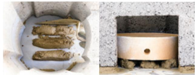
**5** Vienmērīgi uz bloka kontūrām jāuzklāj cementa maisījums. Sekojiet līdzī, lai ventilācijas kanālos bloku iekšpusē neiekļūtu mūrjava. Jāizgriež nākamajā blokā atveri tīrišanas trejgabalam.
